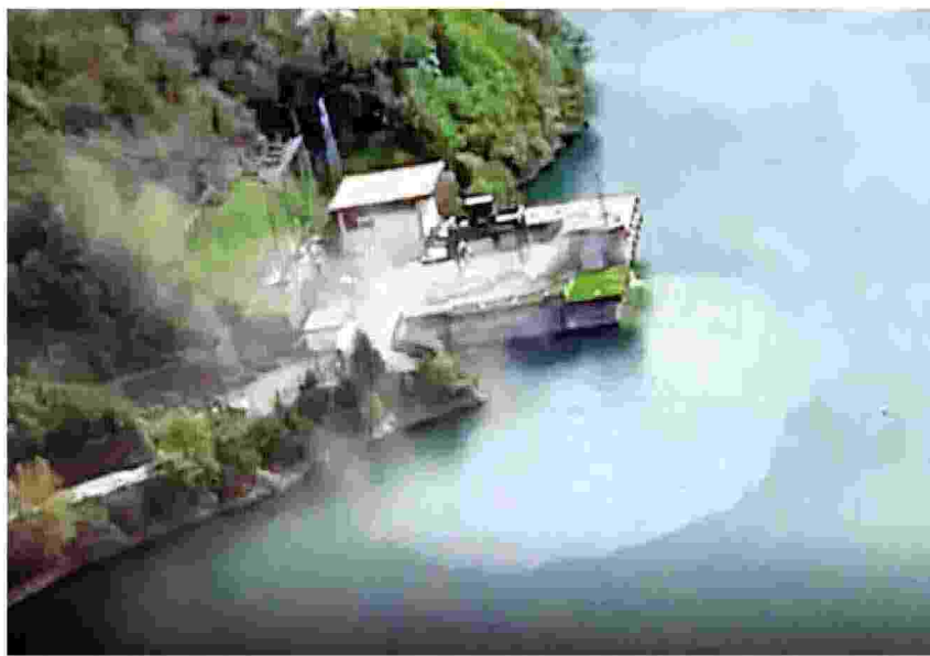
Nelle immagini riprese dall'elicottero dei vigili del fuoco la centrale idroelettrica Enel di Bargi, sul lago artificiale di Suviana, nell'Appennino bolognese
